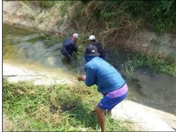
รูปที่ ๒ การกำจัดวัชพืชสาเหตุทำให้คลองตาดคอนกรีตเสียหาย
