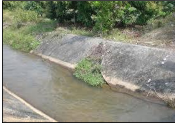
รูปที่ ๓ การชำรุดของคลองตาดคอนกรีต
